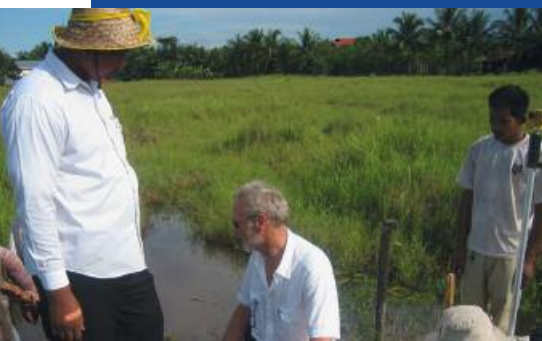
In Kambodscha sorgt Senior Experte Jürgen Mittenentzwei durch Installation einer Abwasseraufbereitungsanlage für sauberes Trinkwasser.
